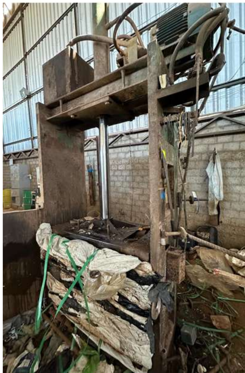
FOTO – 01 VISTA LATERAL DA PRENSA HIDRÁULICA PARA PAPELÃO
