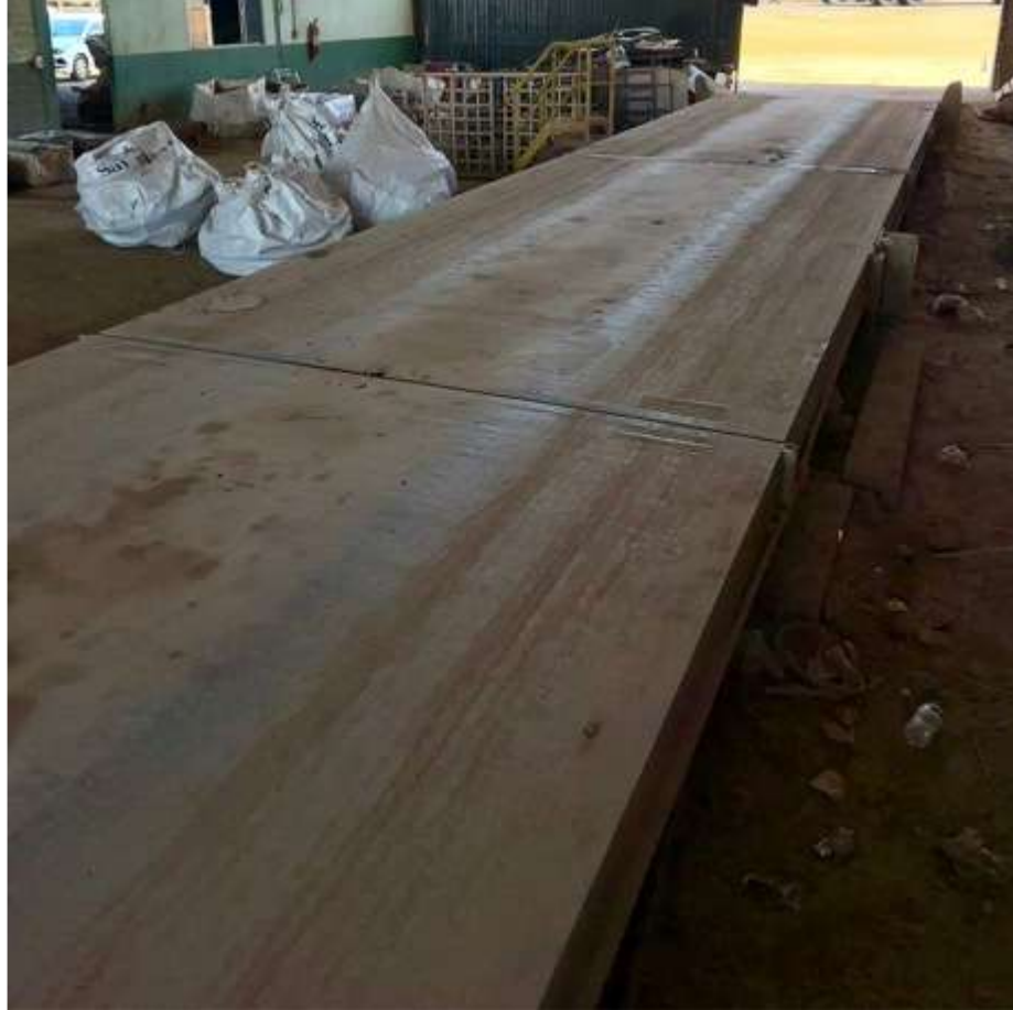
FOTO – 01 VISTA LATERAL DA BALANÇA RODOVIÁRIA
